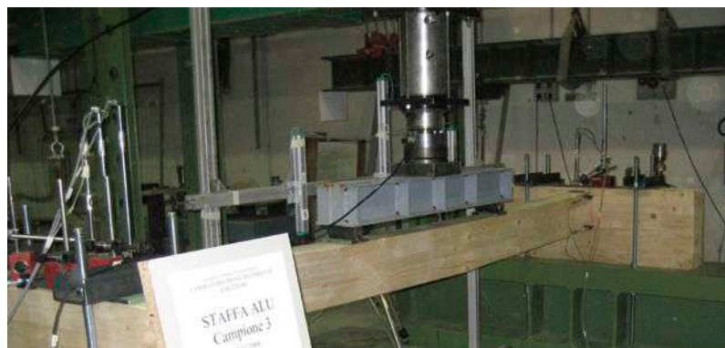
Skúšky na vzorkách skutočnej veľkosti (spojenie hlavný nosník-pomocný nosník).
